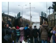
Écluse de Bougival
